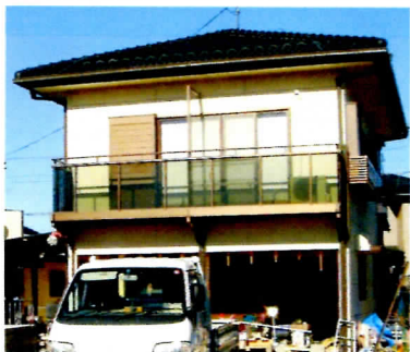
改修工事中「憩いの部屋」
