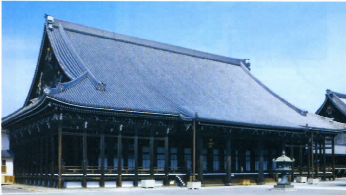
修復された御影堂全景
