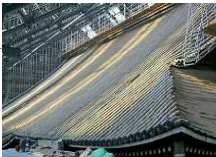
屋根瓦の工事中 西本願寺HPより
